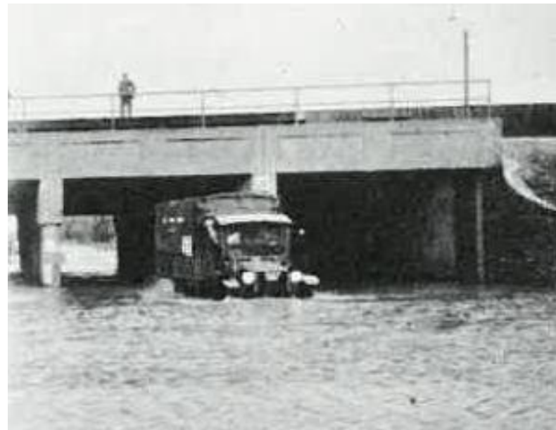
Flossmoor Rd. Viaduct - 1928
